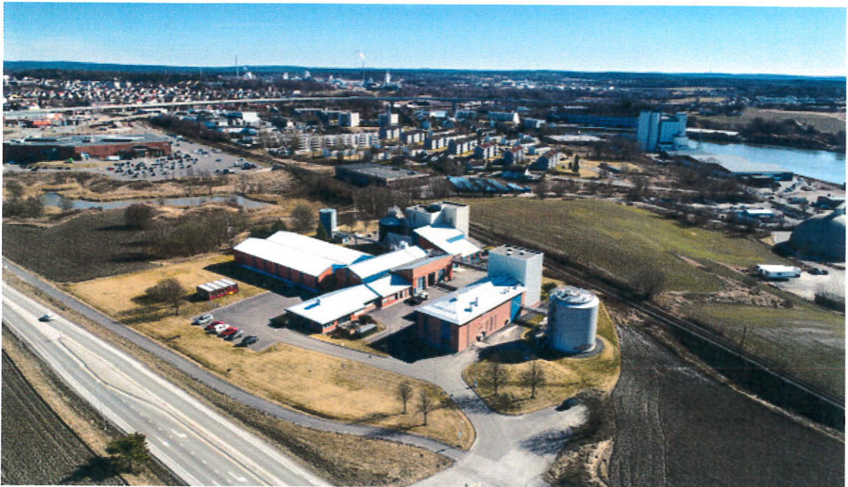
Alvim renseanlegg i Sarpsborg
